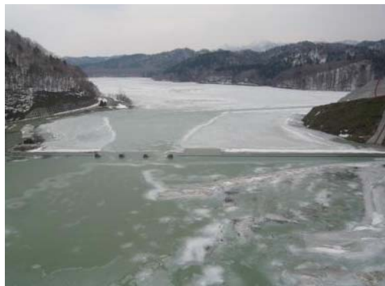
2014/4/9 試験湛水 貯水位 266.9m
