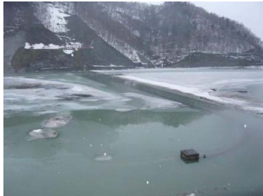
2014/4/10 試験湛水 貯水位 267.2m
