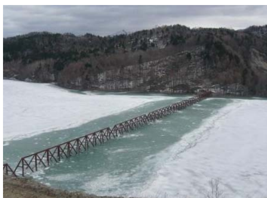
2014/4/18 試験湛水 貯水位 270.2m
