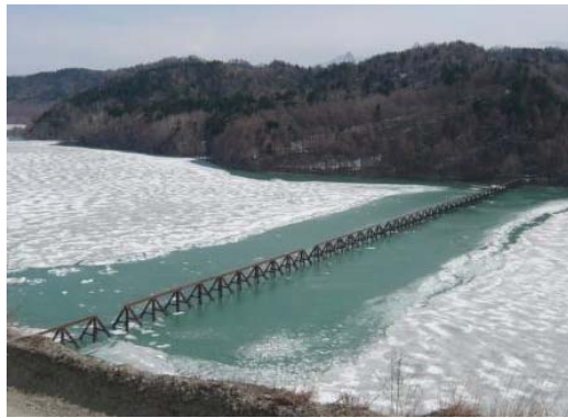
2014/4/22 試験湛水 貯水位 271.9m
