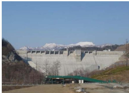
2014/4/23 試験湛水 貯水位 272.6m
