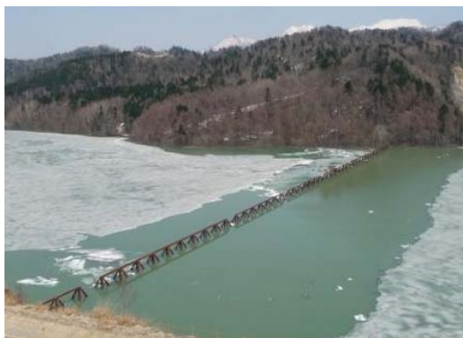
2014/4/24 試験湛水 貯水位 273.3m
