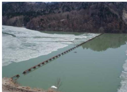
2014/4/25 試験湛水 貯水位 274.3m
