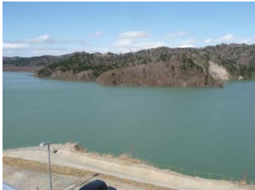
2014/4/28 試験湛水 貯水位 277.7m
