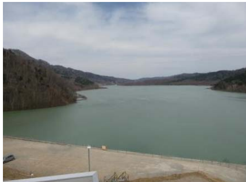
2014/4/30 試験湛水 貯水位 279.5m
