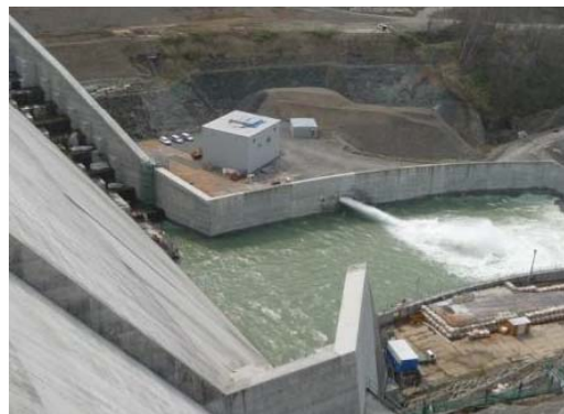
2014/5/8 試験湛水 貯水位 285.4m
