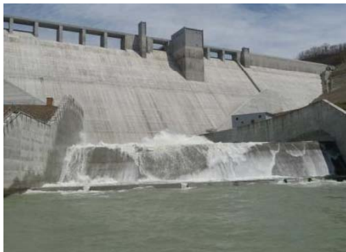
2014/5/12 試験湛水 貯水位 286.4m
