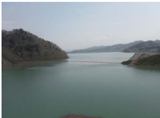
2014/5/14 試験湛水 貯水位 286.8m
