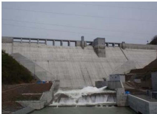
2014/5/15 試験湛水 貯水位 287.1m
