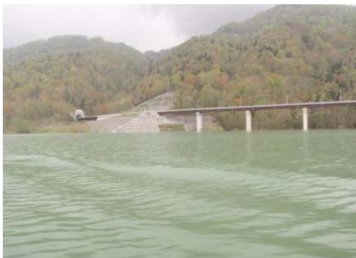
2014/5/21 試験湛水 貯水位 288.2m
