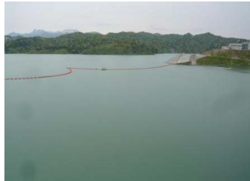
2014/5/26 試験湛水 貯水位 288.4m
