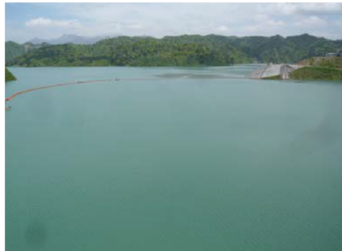
2014/5/28 試験湛水 貯水位 288.5m
