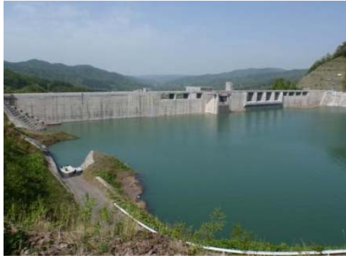
2014/5/29 試験湛水 貯水位 288.6m
