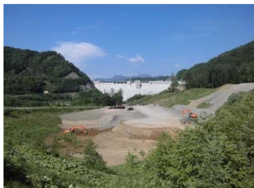
2014/6/4 試験湛水 貯水位 288.5m
