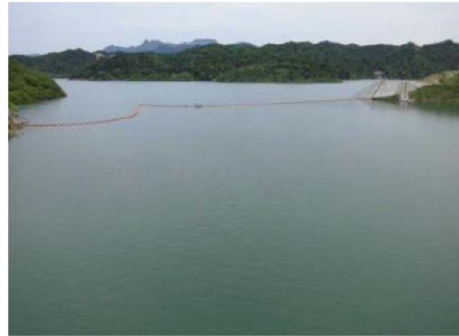
2014/6/6 試験湛水 貯水位 288.4m
