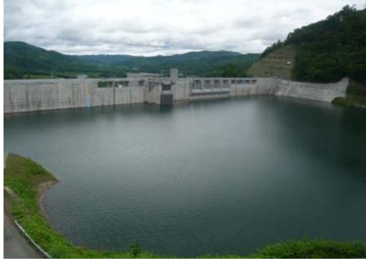
2014/6/11 試験湛水 貯水位 288.1m
