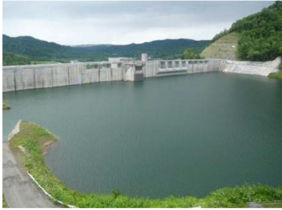
2014/6/13 試験湛水 貯水位 288.1m
