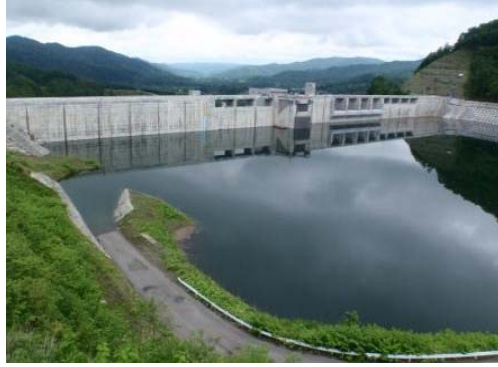
2014/6/17 試験湛水 貯水位 288.8m
