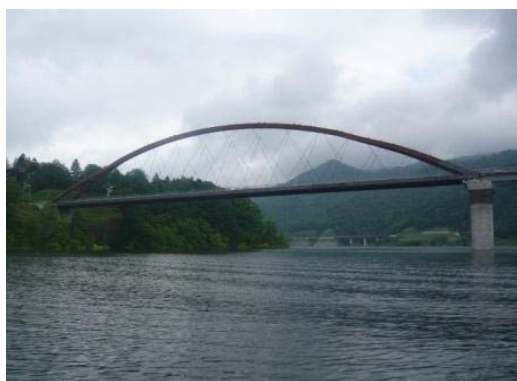
2014/6/18 試験湛水 貯水位 288.8m
