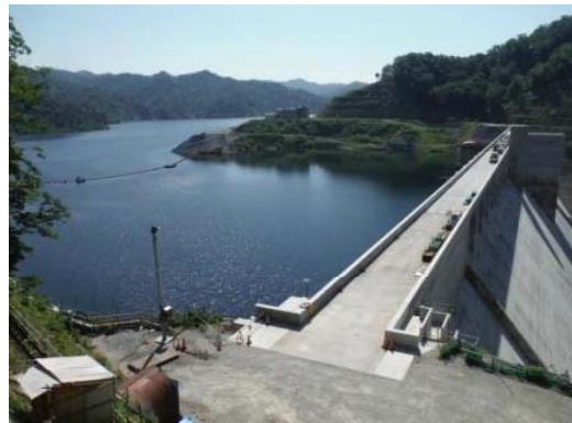
2014/6/26 試験湛水 貯水位 288.5m
