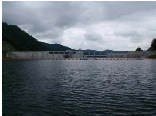
2014/7/2 試験湛水 貯水位 288.1m
