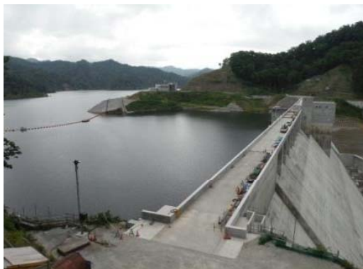
2014/7/4 試験湛水 貯水位 287.8m
