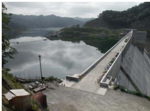
2014/7/7 試験湛水 貯水位 287.4m
