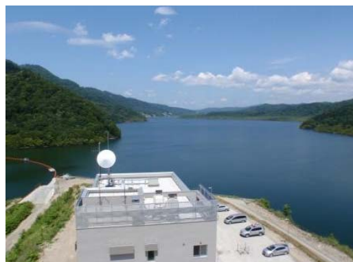
2014/7/8 試験湛水 貯水位 287.3m
