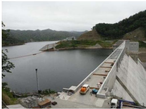
2014/7/22 試験湛水 貯水位 285.3m
