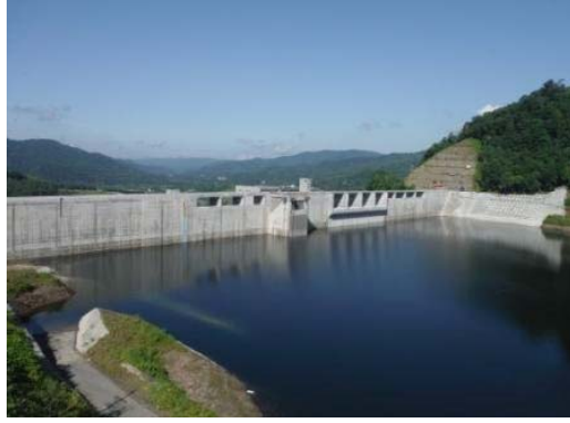
2014/7/24 試験湛水 貯水位 285.3m
