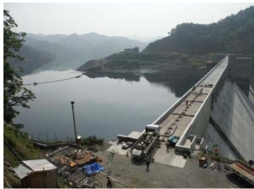
2014/7/30 試験湛水 貯水位 285.2m
