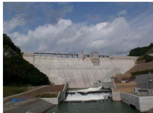
2014/7/31 試験湛水 貯水位 285.1m
