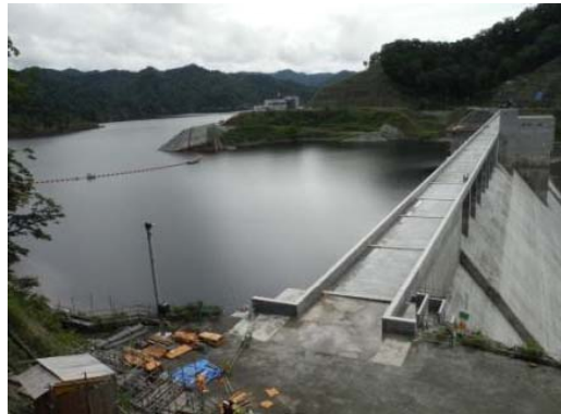
2014/8/6 試験湛水 貯水位 286.3m
