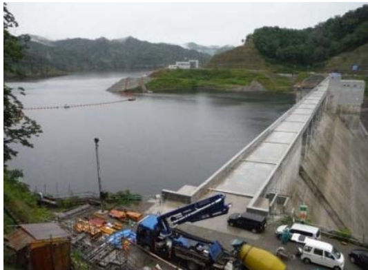
2014/8/7 試験湛水 貯水位 287.1m
