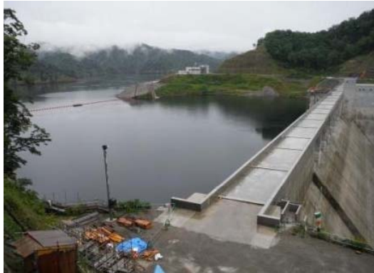
2014/8/8 試験湛水 貯水位 287.5m
