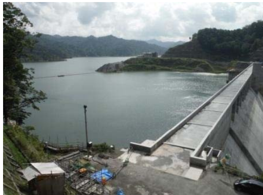
2014/8/13 試験湛水 貯水位 289.7m
