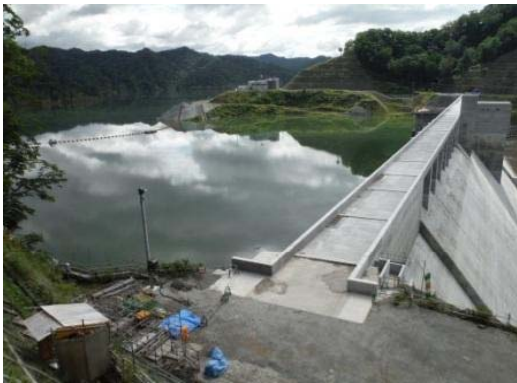
2014/8/14 試験湛水 貯水位 290.0m
