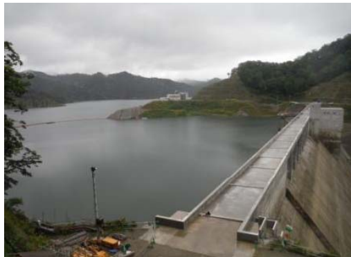
2014/8/20 試験湛水 貯水位 291.0m
