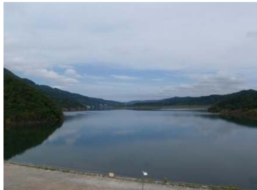
2014/8/21 試験湛水 貯水位 291.8m
