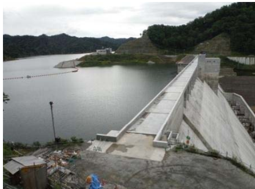
2014/8/25 試験湛水 貯水位 293.5m
