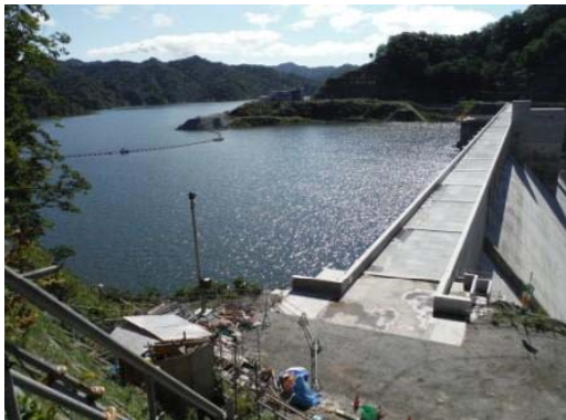
2014/8/26 試験湛水 貯水位 293.7m
