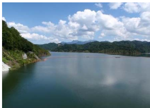
2014/8/29 試験湛水 貯水位 294.0m
