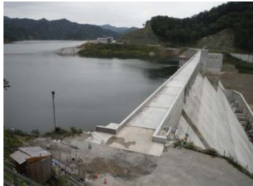
2014/9/4 試験湛水 貯水位 294.4m
