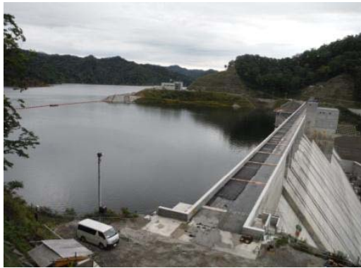
2014/9/10 試験湛水 貯水位 294.9m
