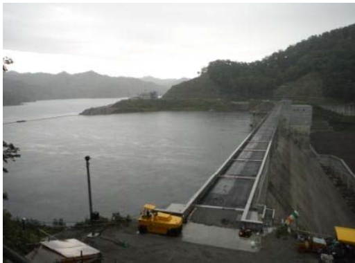
2014/9/11 試験湛水 貯水位 294.9m
