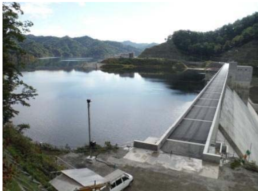
2014/9/17 試験湛水 貯水位 295.8m
