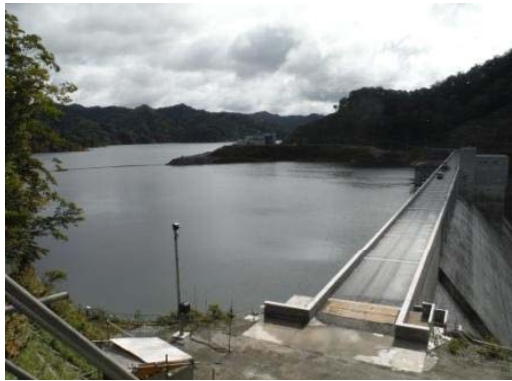
2014/9/19 試験湛水 貯水位 296.0m
