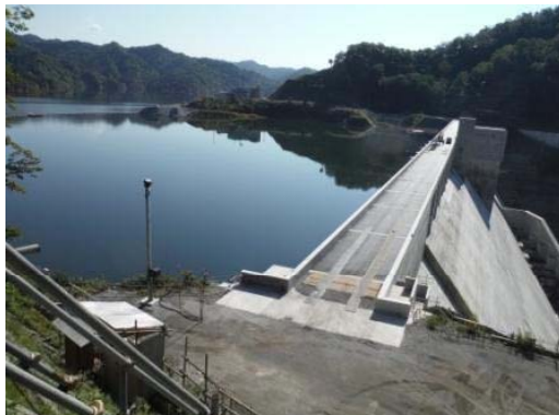
2014/9/22 試験湛水 貯水位 296.3m
