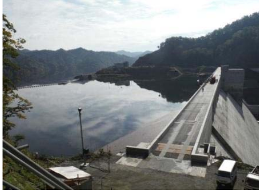
2014/9/25 試験湛水 貯水位 296.5m
