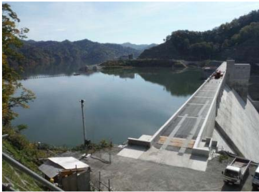
2014/9/29 試験湛水 貯水位 296.6m
